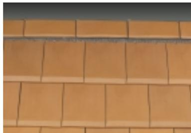
Faîtage réalisé à sec avec faitières-arêtiers angulaires à emboîtement grand modèle, et closoir ventilé, sans emploi de mortier.
