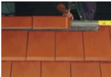
Après mise en place du closoir ventilé, les faitières sont fixées par crochet adapté au modèle, vissé dans la lisse de rehausse.
