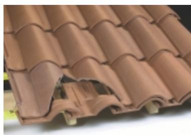
Pose du closoir d'égout, fixé par la tuile du 1<sup>er</sup> rang, par crochet V2 Réf. CRV02. (Le liteau ou le bandeau d'égout n'est plus relevé pour éviter le basculement du 1<sup>er</sup> rang de tuiles).
