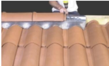
Après mise en place du closoir ventilé, les faîtières sont fixées par crochet adapté au modèle, vissé dans la lisse de rehausse.
