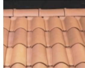
Faîtage réalisé à sec avec tuiles sous-faîtière 1/2 pureau et faîtières 1/2 rondes à emboîtement grand modèle, ne nécessitant pas d'étanchéité complémentaire, sauf protection neige poudreuse.
