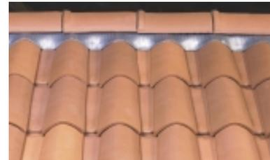
Faîtage réalisé à sec avec faîtières 1/2 rondes à emboîtement grand modèle et closoir ventilé, sans emploi de mortier.
