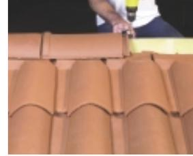
Fixation des faîtières par crochet adapté au modèle, vissé dans lisse de rehausse.
