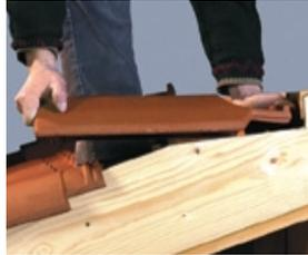
La longueur du versant déterminera l'emploi de la tuile sous-faîtière (1 ou 3/4 ou 1/2 pureau). *Détail de pose "à la lyonnaise" avec découpe du bandeau de rive.*
