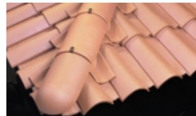
Arêtiers et about d'arêtier 1/2 rond à emboîtement grand modèle posés à sec avec closoirs d'arêtier gauches et droits "cassons", sans emploi de mortier.
