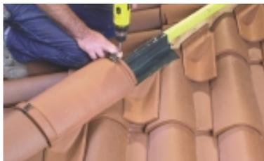
Après coupe des tuiles d'approche, fixation des "cassons" par vis, dans la lisse de rehausse. Mise en place d'une bande complément d'étanchéité et fixation des arêtiers par crochet adapté au modèle.
