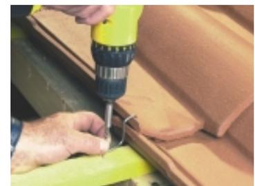
Fixation des tuiles en plain carré pour tenue au vent et à forte pente, par crochet "V2" Réf. CRV02.
