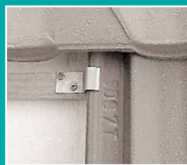
Crochet pour fixation sur écran rigide et sur le liteau.
